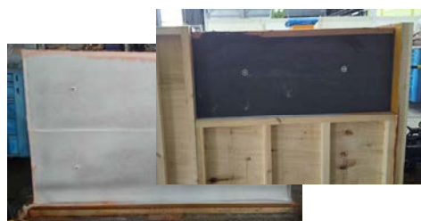
打設後の状況(左:シート残置、右:仕上がり)
