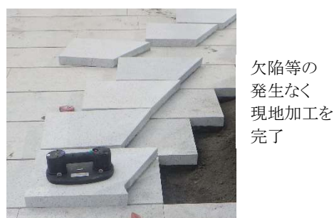
写真3 現地加工および施工の様子
