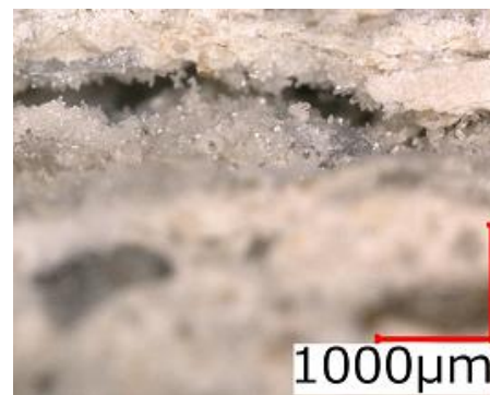
写真 1 TCR2 ひび割れ部分
