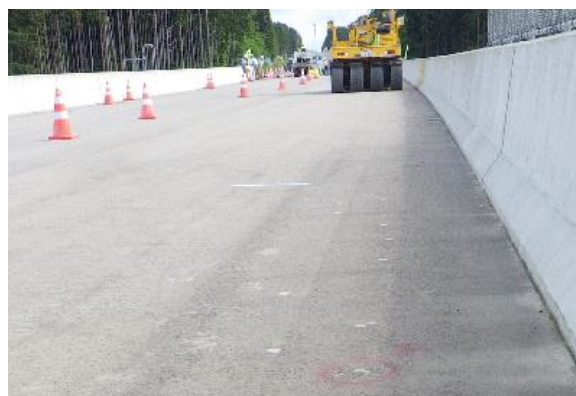
写真-2 転圧による層間接着状況
