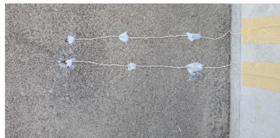
写真-4 電極埋設状況（基層-表層間）
