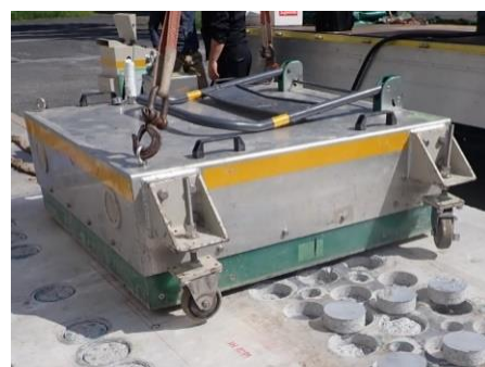
写真-2 IH 加熱ヒーターによる加熱の様子
