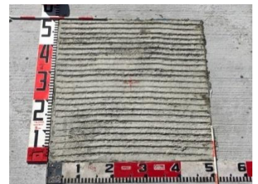
写真-1 粗面仕上げの一例 （ポットホール補修箇所）
