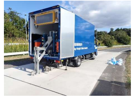
写真-2 荷重伝達率測定状況
