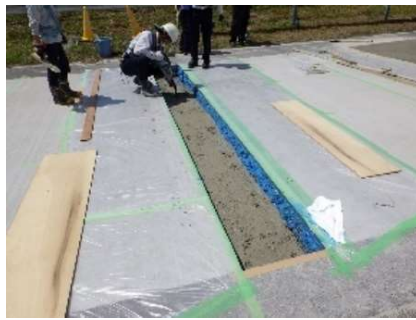
写真-1 実大供試体構築状況
