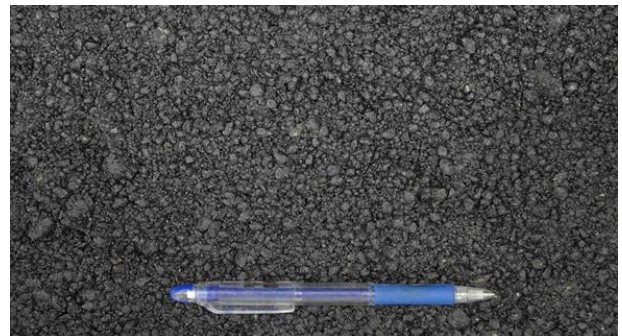
写真-2 No.2 きめが潰れていない粗い仕上がり
