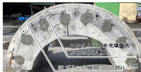
写真-3 吹付け試験体載荷後
