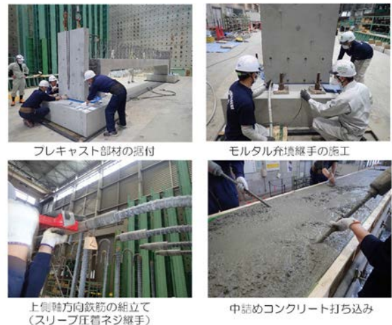
写真2 施工状況の一例（頂版）
