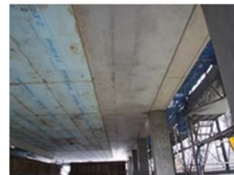
写真-1 CO 2 吸収コンクリートの適用部位
