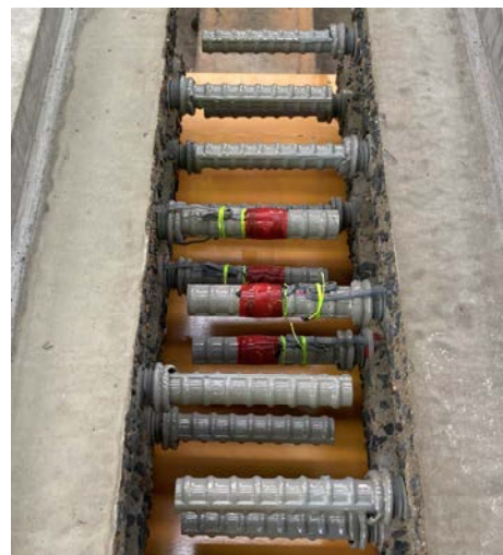
写真-1 EG ジョイント設置状況
