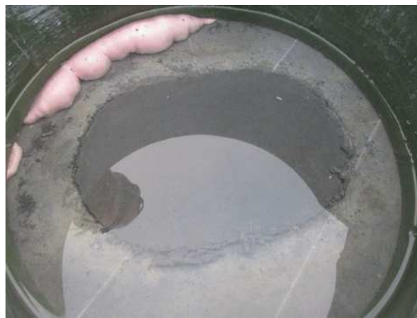
写真-2 スタッドジベル孔の水張り
