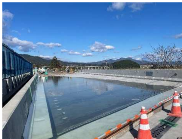
写真-1 斉川橋(上り線)における水張試験
