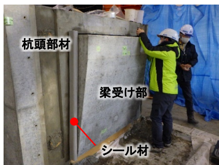
(a) 杭頭部材設置
