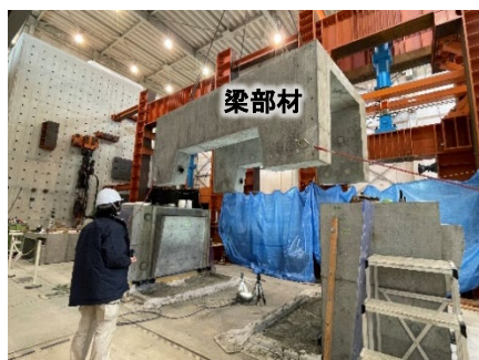
(b) 梁部材架設
