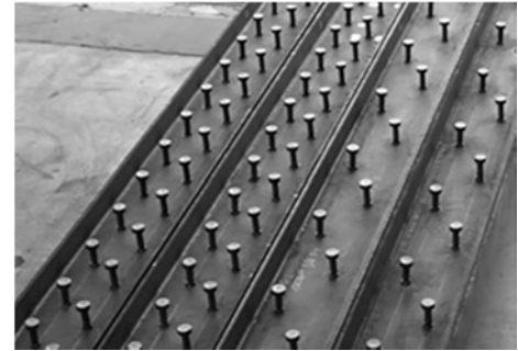
写真-1 I 形鋼にスタッド配置した補強材
