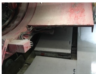
写真-2 現地設置状況
