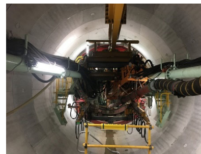
写真-3 現地設置後状況
