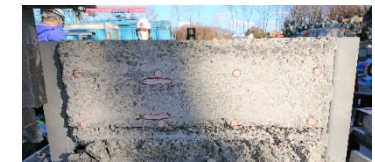
写真-4 切削面の状況(ケース-2)
