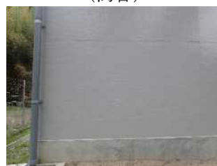
写真-5 ふっ素塗装(変状なし)
