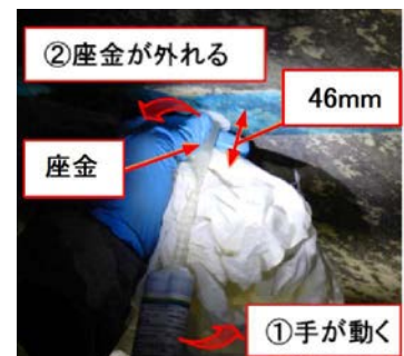
写真-3 マニュアルガンでの施工時の座金の逸脱
