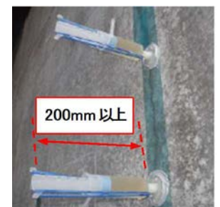
写真-2 自動注入の状況
