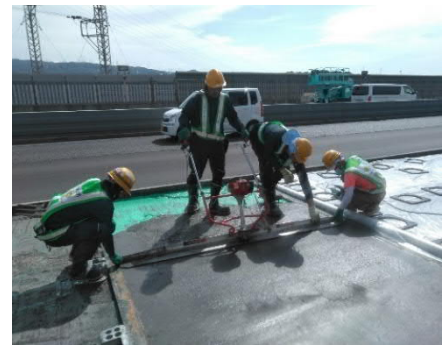
写真-2 大型エンジンスクリード使用
