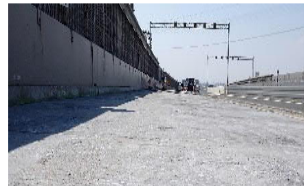
写真-3 施工完了全景
