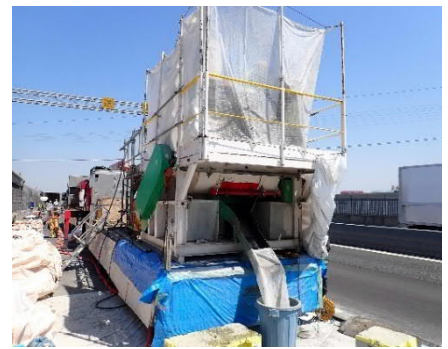
写真-1 車上プラント配置状況
