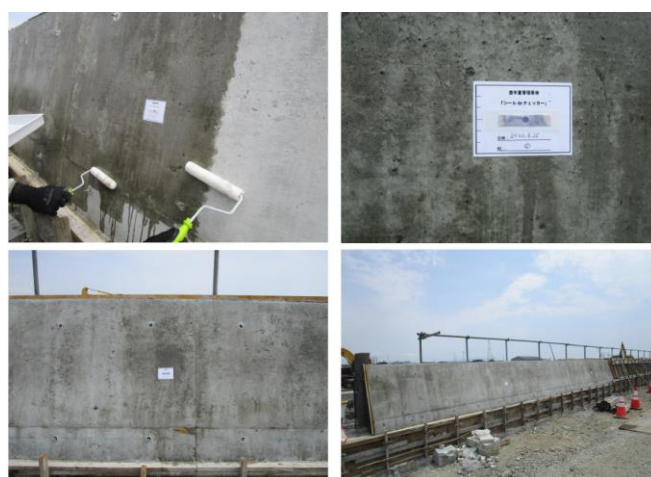
図5 実施工例2(新設堤防への適用)
