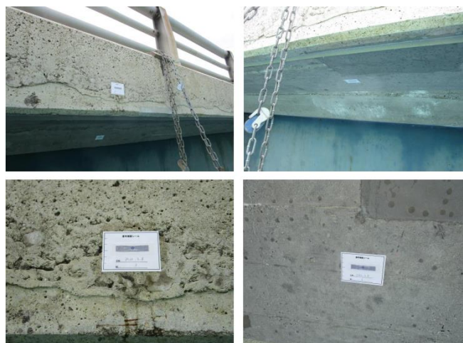
図4 実施工例1(橋梁補修工事)
