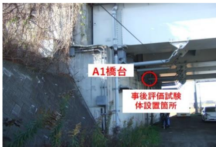
図4 A橋のA1橋台外観
