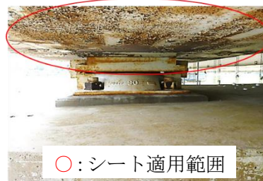
図3 老朽化した更新前の変位制限装置下フランジ面
