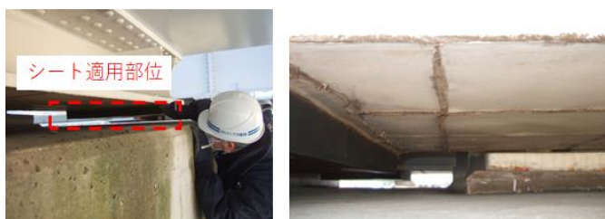
図7 上り線側の対象部位 (右：防食シート外観)
