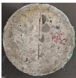
図-1. 人工ひび割れの様子
