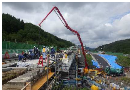
写真-1 BFS コンクリートの場所打ち状況
