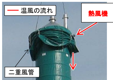
図-3 二重風管設置状況
