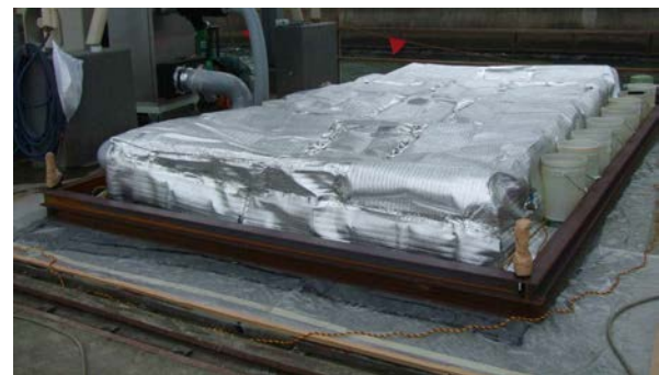
写真-2 炭酸化養生状況
