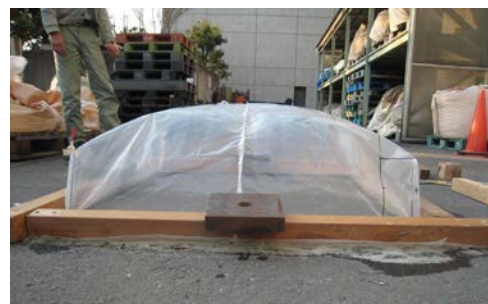
写真-1 漏気試験の状況
