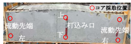
写真-1 脱型後の状況とコア採取位置
