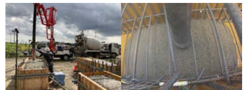
写真-2 コンクリートの打込み状況
