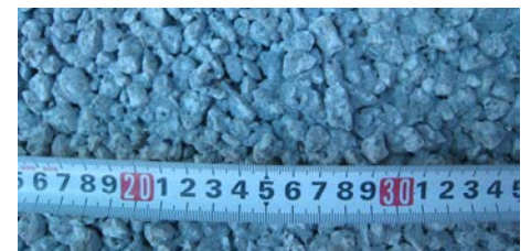
写真-1 洗出しの状況
