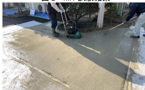
写真1 施工状況
