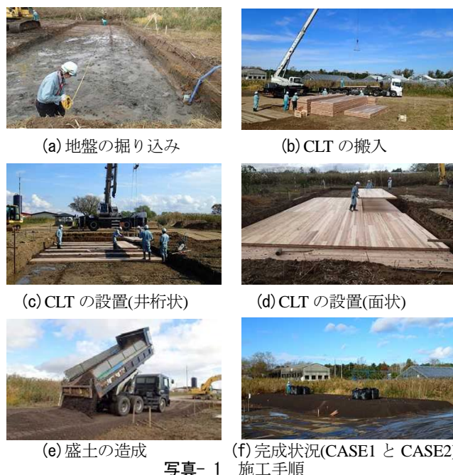
写真-1 施工手順
