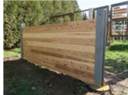
写真1 CLT 遮音・防護柵プロトタイプ
