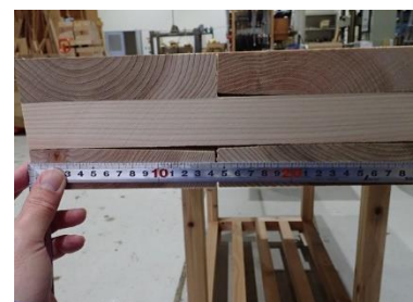
図-4 積層間の隙間 (No.5)
