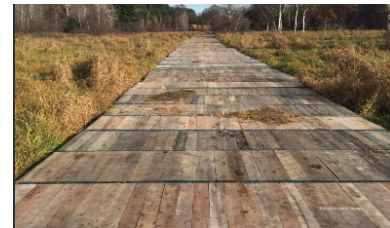
図-1 CLT を用いた仮設道路 1)
