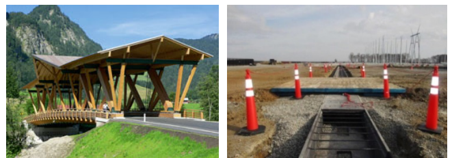
図-2 CLT を用いた橋 1), 2)
