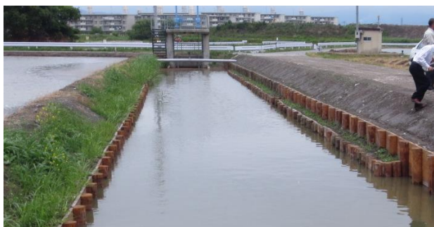
写真-1 設置直後の試験施工現場と試験杭群 (右側の低い部分)
