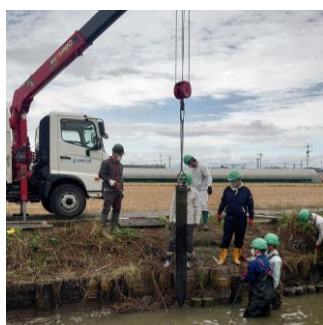
写真-2 試験杭の引き抜きの様子
