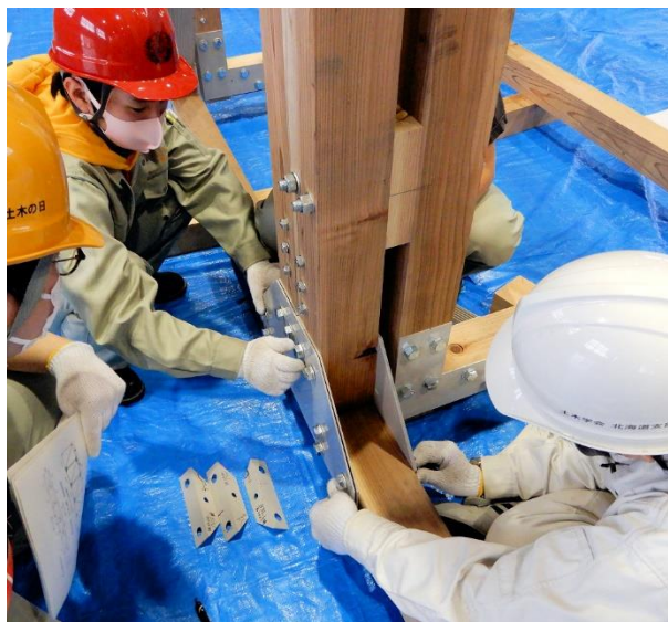
写真-2 パネル同士の連結作業
