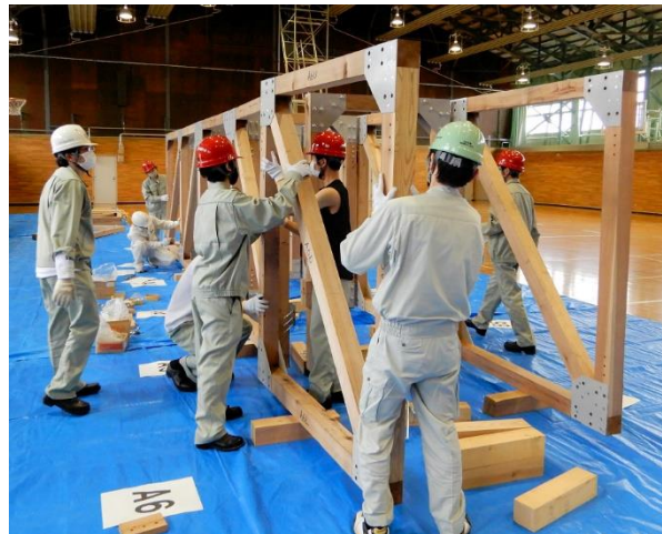
写真-1 人力によるトラスパネルの連結
