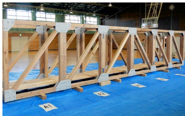
写真-3 完成した木製ハウトラス橋
