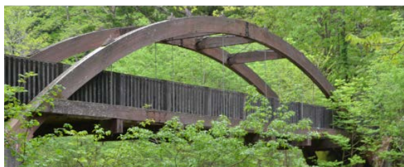
図-1 めおと橋の外観
