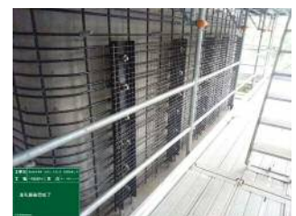
写真-1 中間貫通 PC 鋼材配置完了
