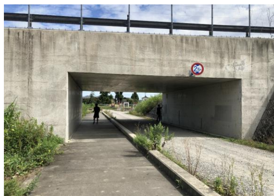
図-1 ボックスカルバート全景
