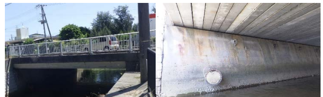
写真-1 対象橋梁外観・桁下状況
