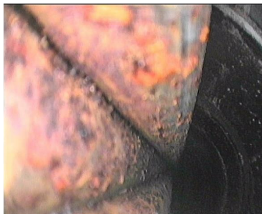
図 6 削孔調査法による撮影画像
