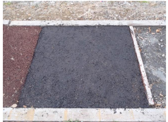
写真-3 養生完了後
