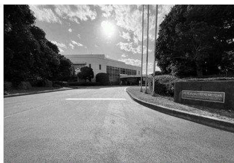
図2 合成炭カルを適用した施工現場（施工後）
