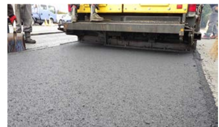
写真-3 敷均し状況
