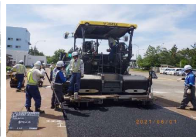
図-3 敷均し状況
