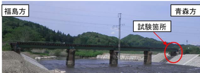
写真-3 試験施工箇所および部材設置状況
