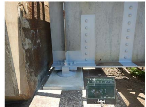
写真-5 沓座打ち替え完了
