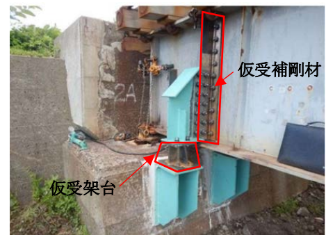
写真-4 仮受部材設置状況
