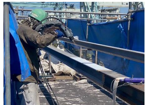
写真-1 Zn-Al 溶射施工の様子
