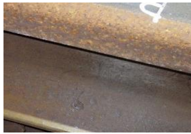
写真-3 底部上面のふくれ
