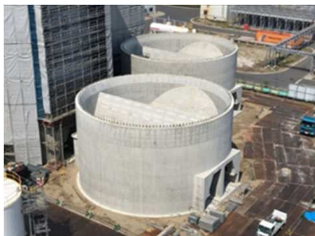
写真-2 施工完了写真
