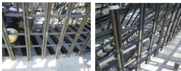
写真-1 閉塞部施工状況
