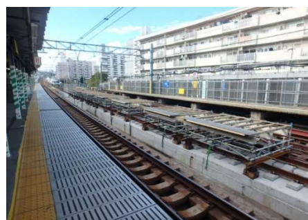
写真 1 ユニット式仮ホーム仮置き
