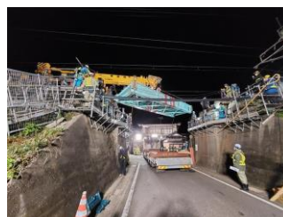
写真-3 橋桁架替状況
